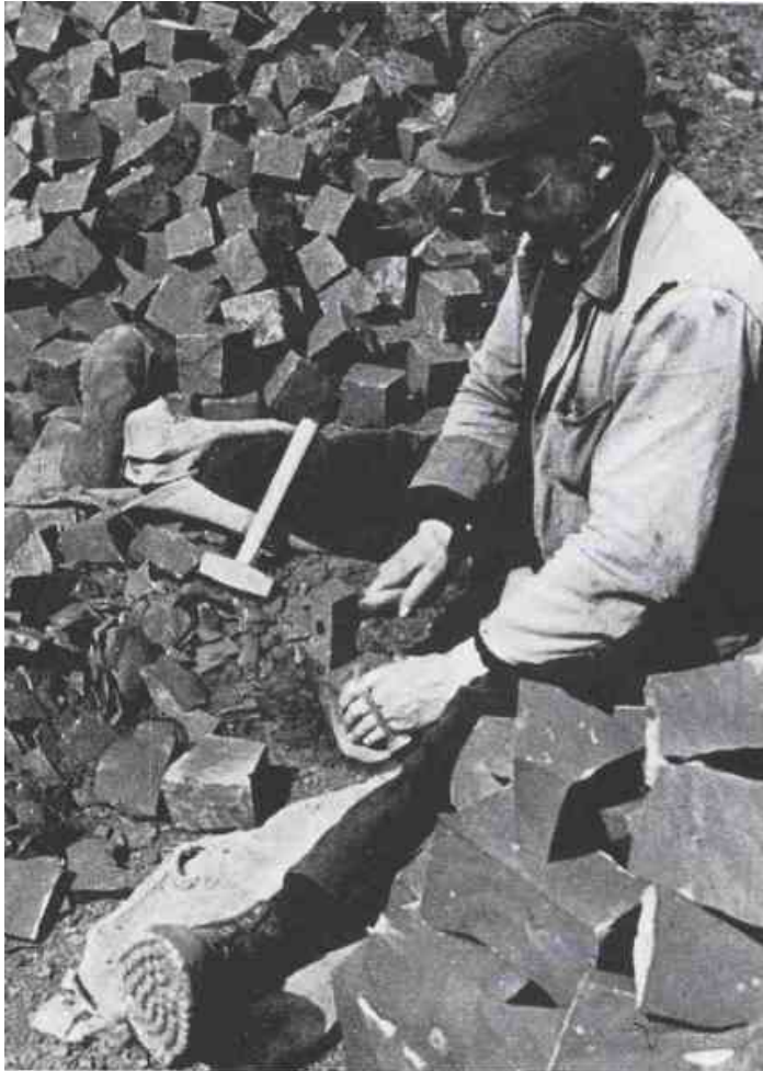
Abbildung 8: Pflastersteine fanden für den Bau von Straßen und Trottoirs, zur Befestigung von Plätzen und Bahnsteigen regen Absatz. Der ‚Steinschläger‘ oder ‚Steinkipper‘ fertigte gekannt meist aus Säulenmaterial regelmäßige Würfel an. (50 Jahre Basalt A.-G. Linz a. Rh. 1888 - 1938)
