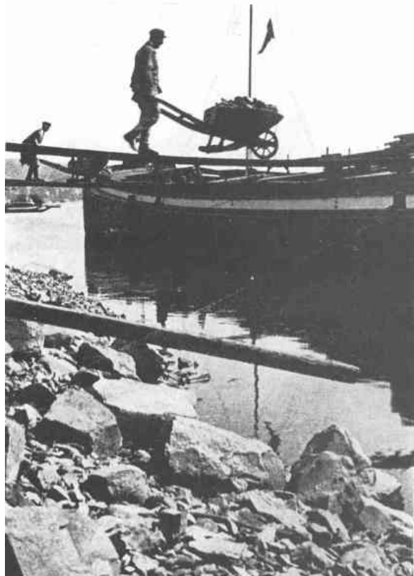
Abbildung 25: Beladung der Schiffe am Rhein mit Basalt durch die „Schürreser“ (50 Jahre Basalt A.-G. Linz a. Rh. 1888 - 1938)
