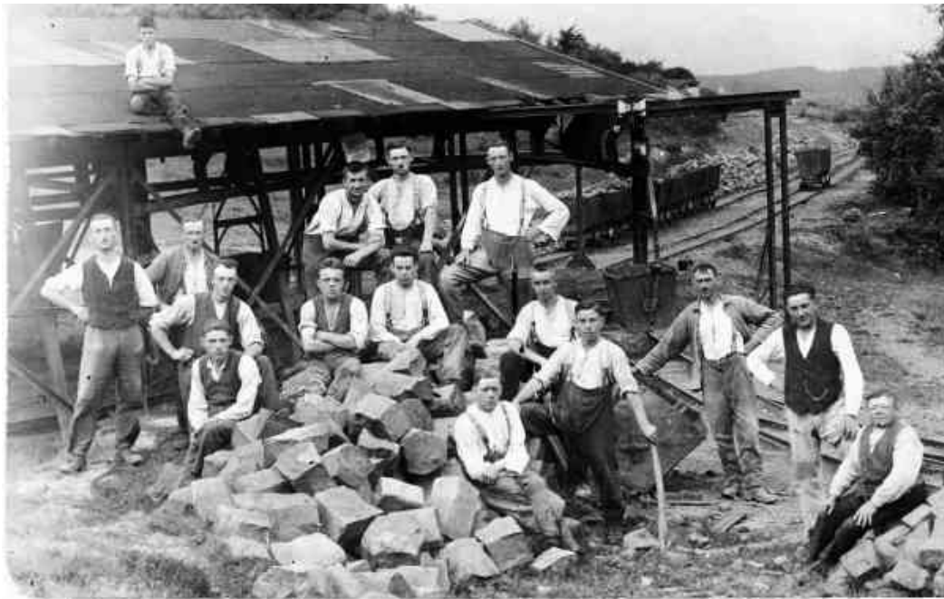
Abbildung 17: Bruchmeister Wilhelm Weißenfels aus Hohn mit seiner Mannschaft um die Mitte der 1920er-Jahre an der Drahtseilbahnstation der Firma Uhrmacher am ‚Hüvvel‘ in Vettelschoß. Von dort wurde das in den Steinbrüchen des Geißen- und Türkenhügels geförderte Basaltgestein in Seilbahnloren zum ‚Brecher‘ (Brecheranlage) nahe des Vettelschossener Bahnhofes transportiert, zu Splitt (Kleinschlag) verarbeitet oder direkt in Eisenbahnwaggons verladen.
