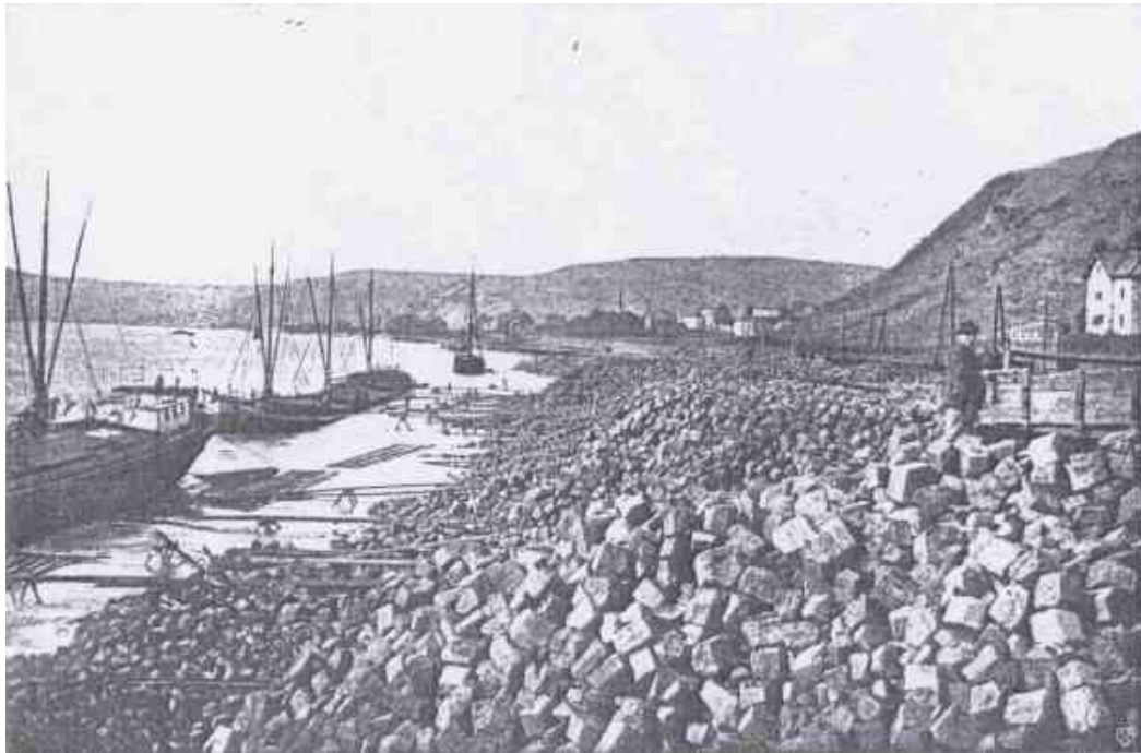
Abbildung 24: Die Schiffsbeladung noch mit der „Schürreskaar“ (Schubkarren) – später durch Kräne oder direkt aus den Seilbahnloren in modernere Rheinkähne (Basalt-Actien-Gesellschaft Linz am Rhein 1888 - 1913)
