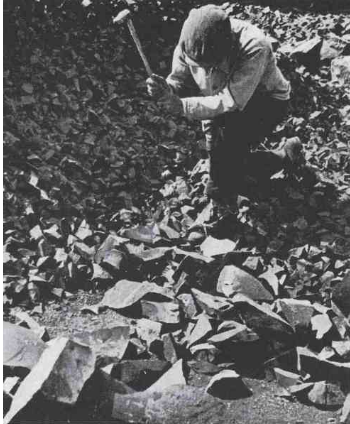
Abbildung 7: Ein ‚Steinschläger‘ sorgte für die Bedarfsdeckung an ‚Kleinschlag‘ für den Wasser- und Wegebau sowie für die Gleisbettung zur Erweiterung des Eisenbahnnetzes. (50 Jahre Basalt A.-G. Linz a. Rh. 1888 - 1938)
