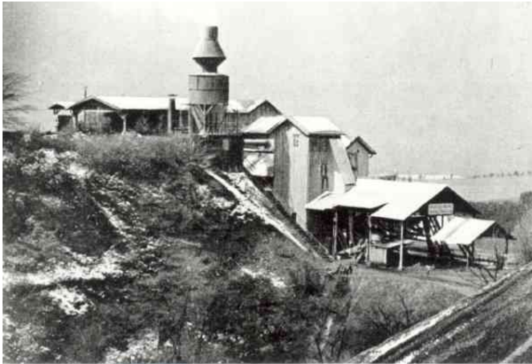
Abbildung 21: Die Betriebsstätte ‚Mehrberg‘ oder ‚Düstermich‘ mit einem Steinbruch, einer modernen Brecheranlage und einer Seilbahn an den Rhein. (Bild: Matthias Ewenz, Linz)
