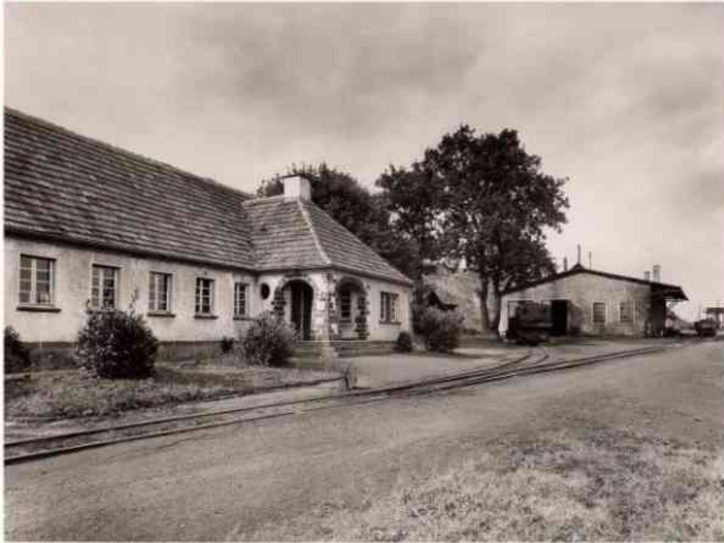
Abbildung 18: Aufenthalts-, Wasch- und Duschkabine, Magazin, Küche, Heizungskeller und Büro – Lokomotivschuppen, Werkstätten (Schlosserei, Sägerei/Stellmacherei und zwei Schmieden) sowie im Hintergrund der Wasserbehälter am Willscheiderberg im Jahre 1960/1961 (Bild: Familienfundus)
