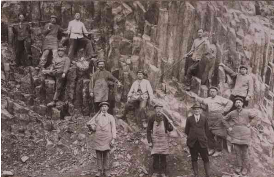
Abbildung 13: Im Steinbruch des Wöls- oder Willscheiderberges wurden Säulen maßgerecht gebrochen. Der ‚Bruch‘ oder ‚Abfall‘ ist von den ‚Steinschlägern‘ weiter bearbeitet worden oder gelangte in die Brecheranlagen bzw. später in das Schmelzbasaltwerk. (Bild: Ernst-Dieter Meyer, Niederwindhagen)
