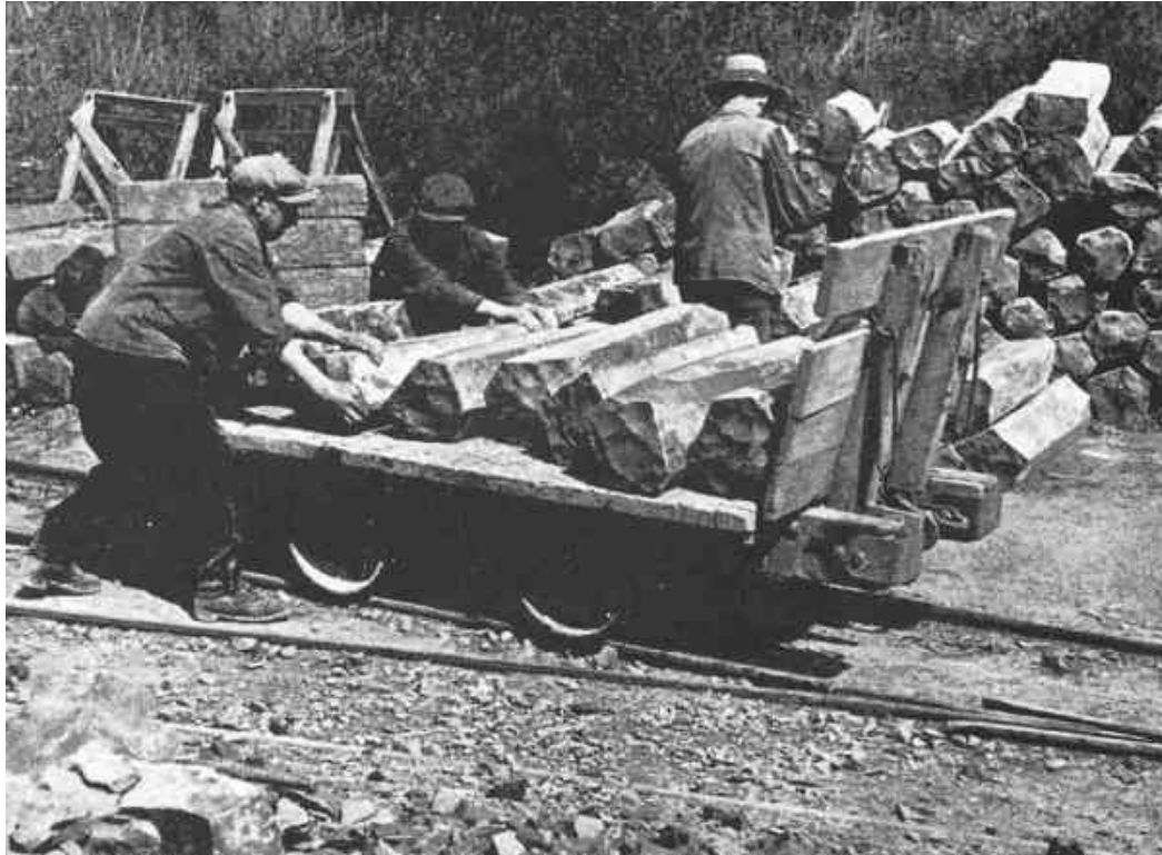
Abbildung 6: Verladung von Säulen im Steinbruch auf den ‚Hunt‘ zum Transport an den Bremsberg (50 Jahre Basalt A.-G. Linz a. Rh. 1888 - 1938)
