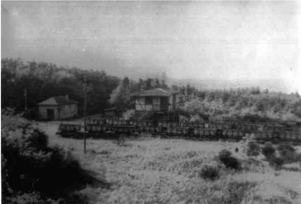
Abbildung 16: Aufenthaltsraum mit Magazin und Aufzugsgebäude. Davor der Wagenpark. (Bild: Elisabeth Kretz geb. Steffen, Vettelschoß)
